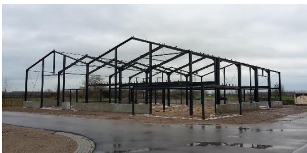
Foto: De bouw van gebouw 9C is begonnen
